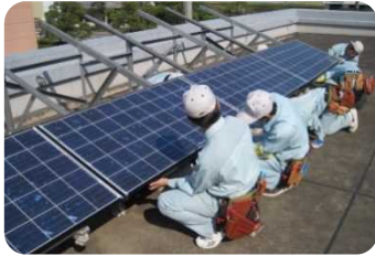
太陽光発電設備工事実習の様子
