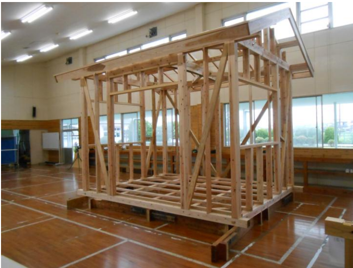
④木造倉庫（切り妻）
